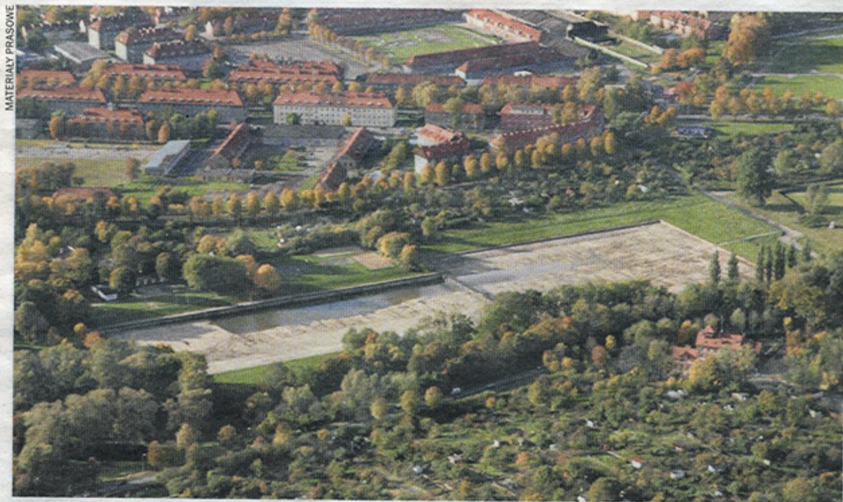
W tym miejscu ma stanąć centrum sportowo-rekreacyjne z aquaparkiem
